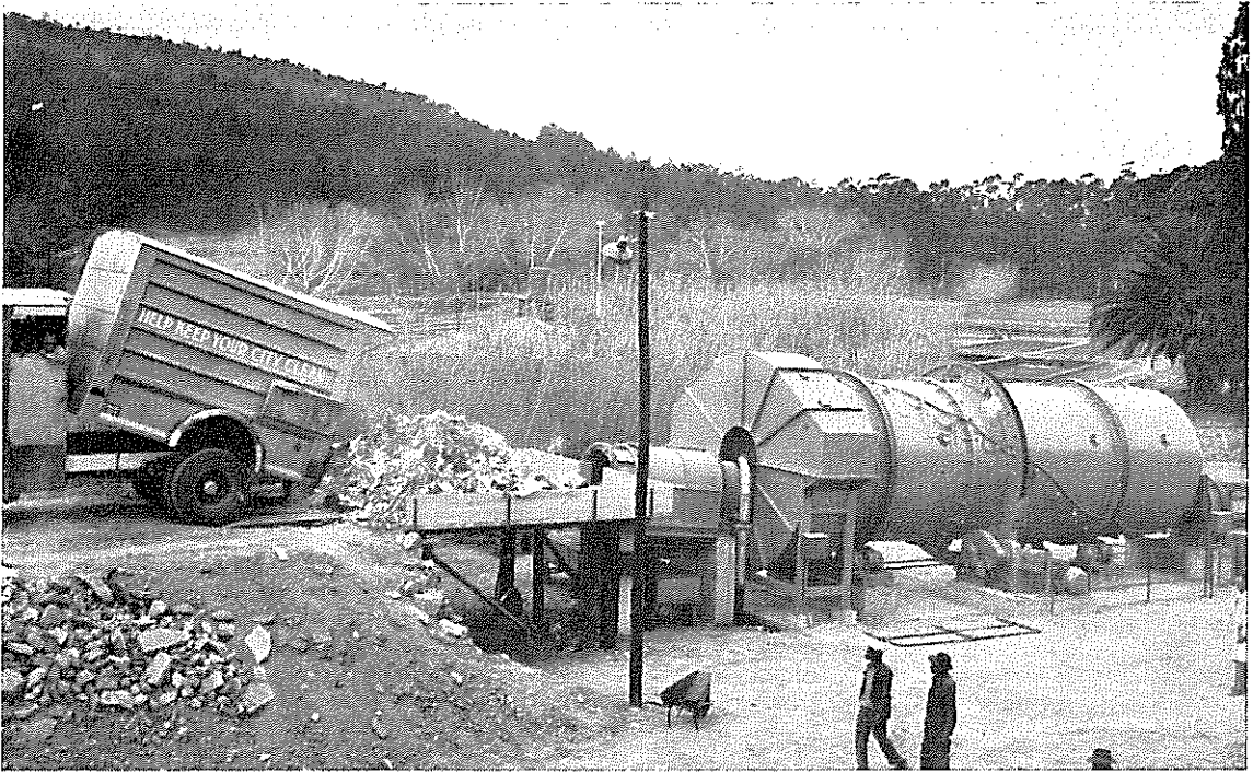
Nasionale Instituut vir Waternavorsing: 'n Proefinstallasie om die omsetting van stadsafval in kompos te bestudeer
