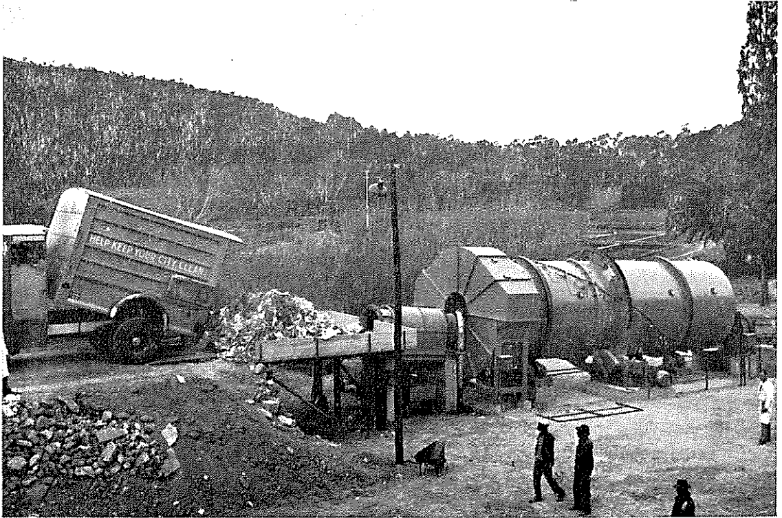
Proefinstallering om die verwerking van munisipale afval in kompos te bestudeer
