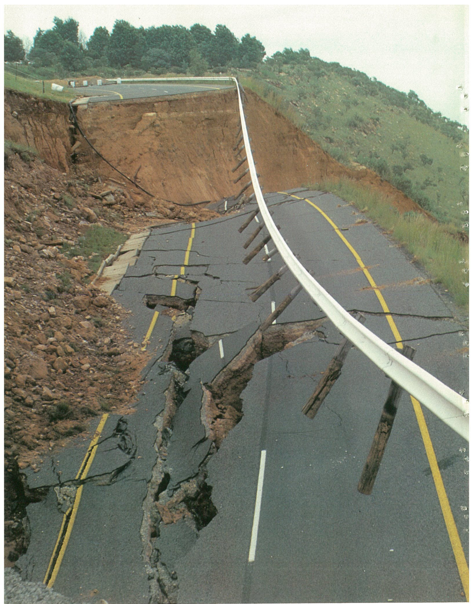
Die Nasionale Instituut vir Vervoer- en Padnavorsing bestudeer die invloed van boumetodes, materiaal en dreinerings op verskillende padontwerpe, en ondersoek die moontlike oorsake van padswigting soos dié op die foto, wat in die Krugersdorpgebied voorgekom het.
